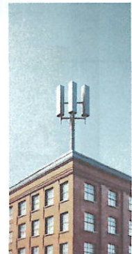
Edificios y/o sus Azoteas
