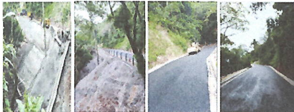
Figura 2. Construcción de muro de concreto reforzado y muro de suelo apilado
