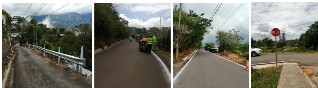
Figura 11. Instalación de barandas de protección, demarcación horizontal y señalización vertical.
