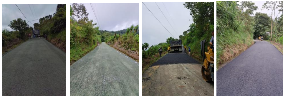
Figura 4. Ejecución de trabajos Los Godínez, Sabanillas.
