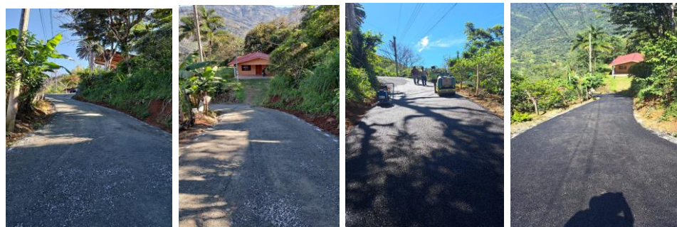
Figura 6. Ejecución de trabajos Edgar Calderón (Enrique Mora).
