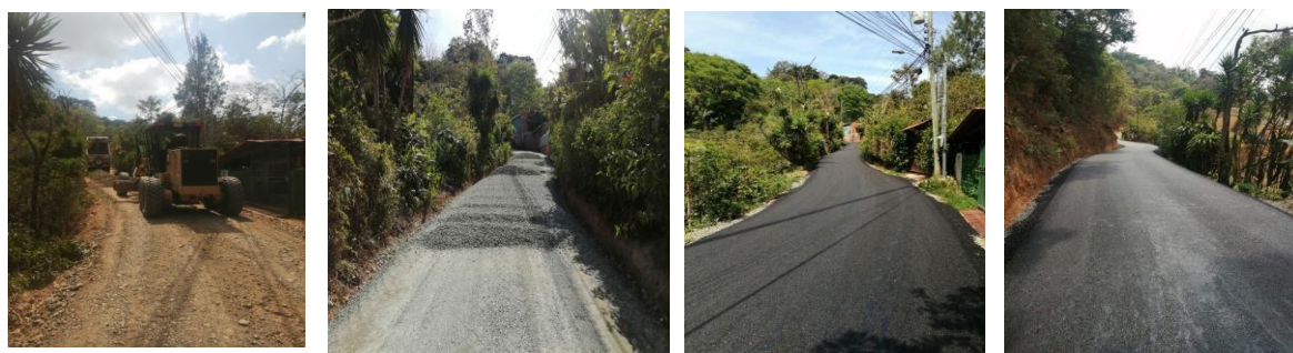
Figura 11. Ejecución de trabajos San Roque.
