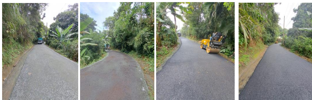
Figura 7. Ejecución de trabajos Barrio San Martín (Chirraca).
