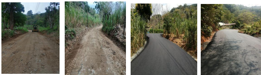
Figura 10. Ejecución de trabajos Alto Los Mora.
