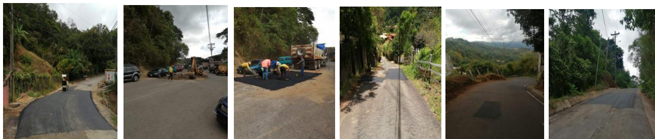
Figura 11. Ejecución de los trabajos de bacheo caminos varios.
