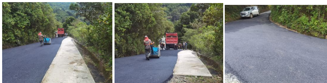
Figura 8. Ejecución de trabajos Mario Rivas.
