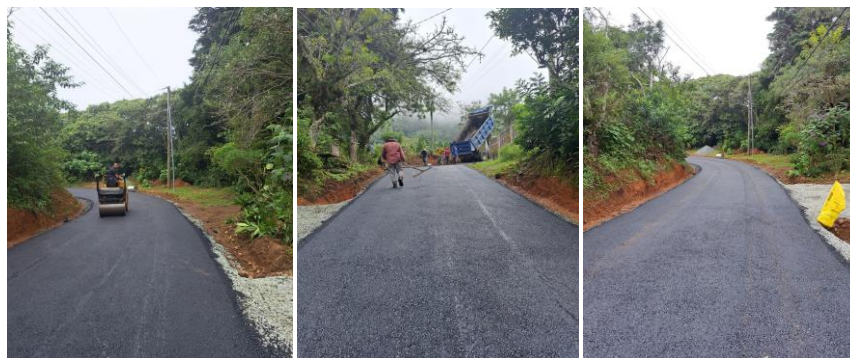
Figura 5. Ejecución de trabajos Alto Los Granados.
