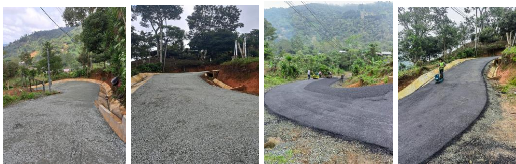
Figura 3. Ejecución de trabajos Los López – Palmichal.
